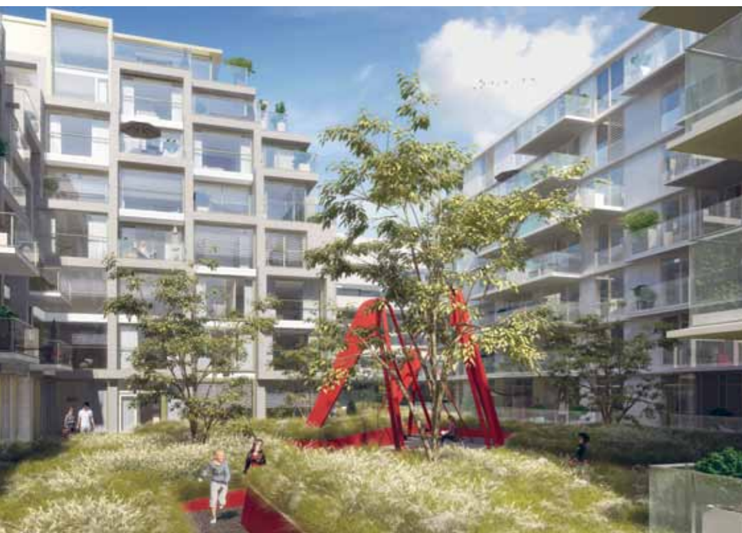
1_ Op het voormalige Shellerrein Overhoeks realiseert Amvest met Ymere ruim 1.600 huur- en koopwoningen.
